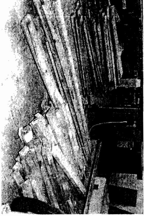
الشكل رقم (٨) : الأختاب بعد تفكيكها وإزالة ما بها من مسامير و تهيأتها للتجهيل.
